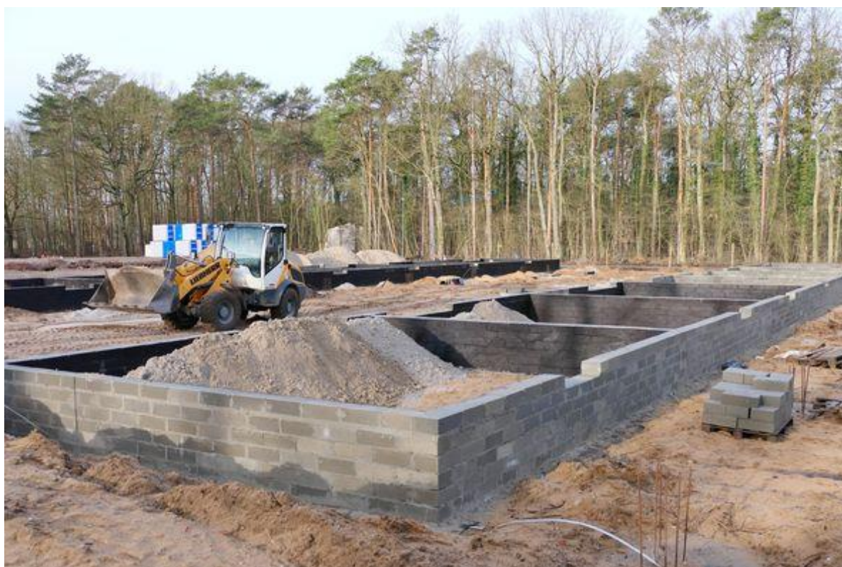
Nowe Czarnowo – budowa osiedla mieszkalnego
