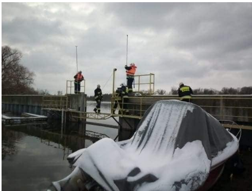
Zakładanie belek przeciwpowodziowych
