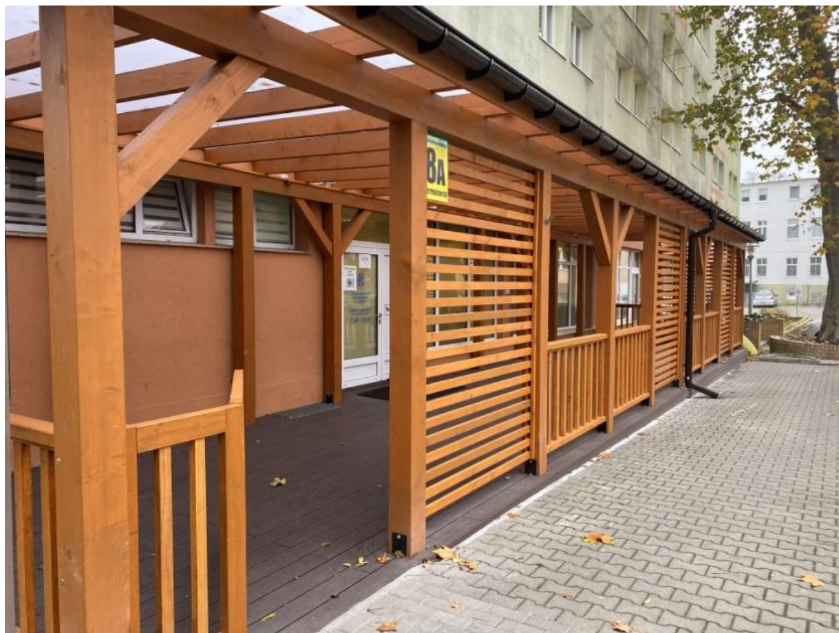
Budowa zadania przed budynkiem Środowiskowego Domu Samopomocy w Gryfinie
