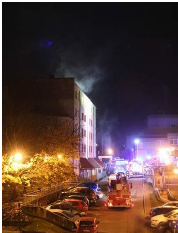
Pożar dachu przy ul. Krasieńskiego w Gryfinie
