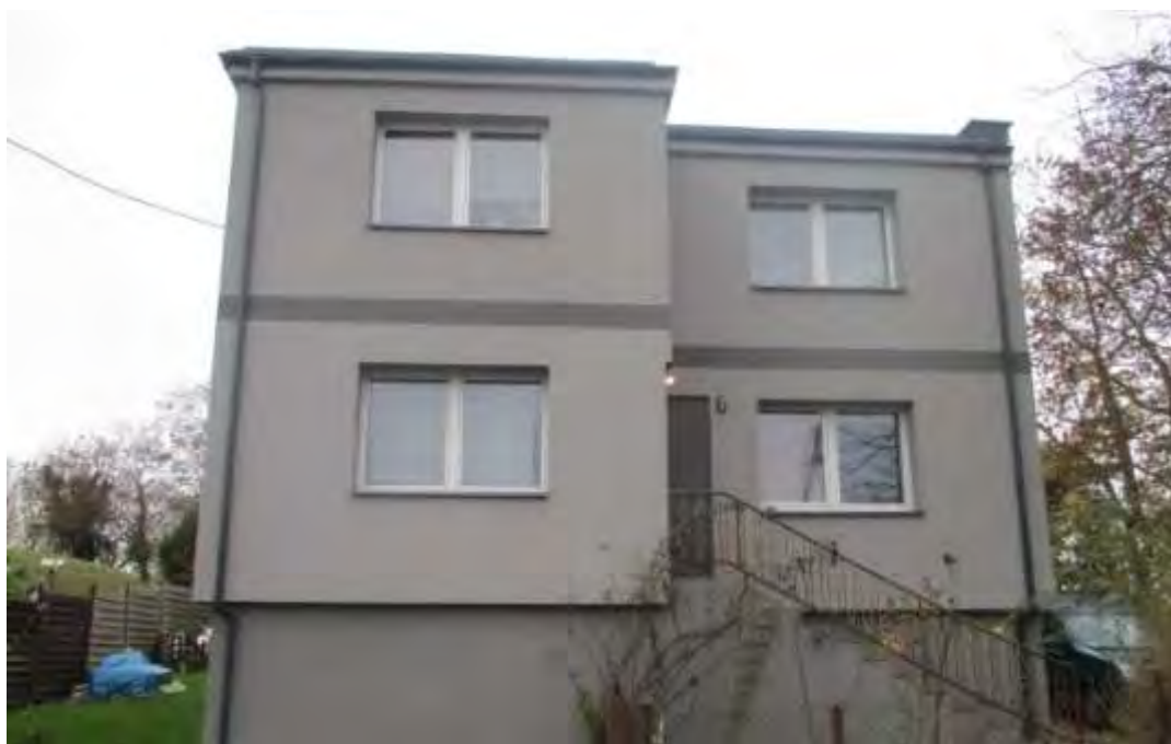
Fot. Budynek mieszkalny po termomodernizacji
